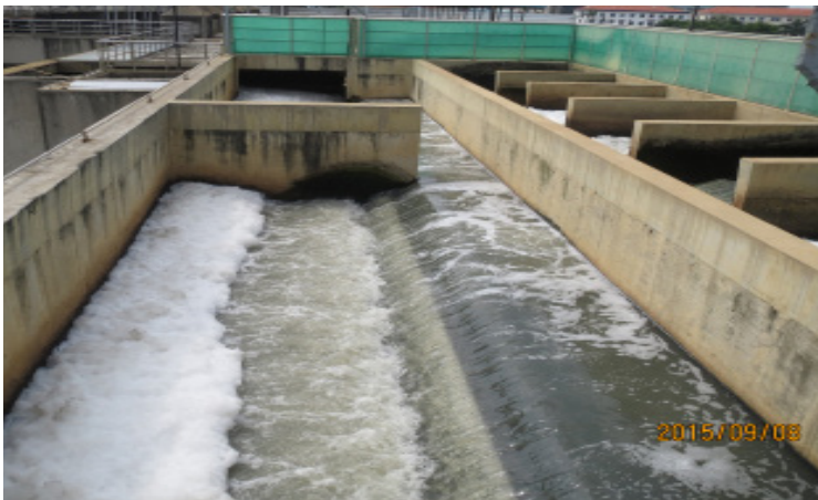
湖濱南路汚水処理場の好気生物反応槽の現場 Aeration tank in Hubin Nanlu Sewerage Treatment Plant
