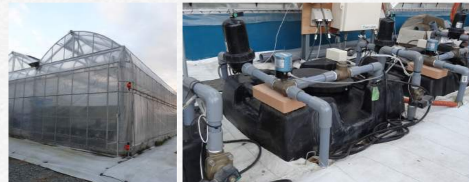
図4-12 施設の周辺やタンク周辺をシートで覆うことで、土砂の侵入を防ぐ
