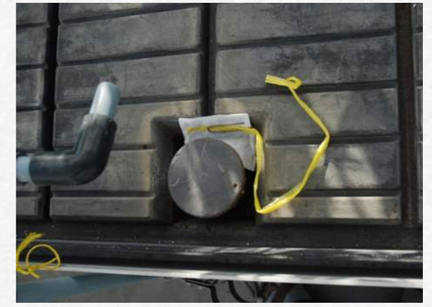
図3-12 ベンチの排水口に設置
