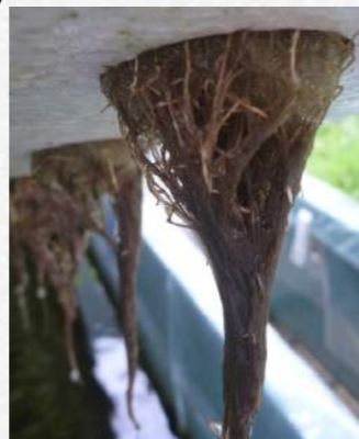
根が暗褐色水浸状に腐敗
