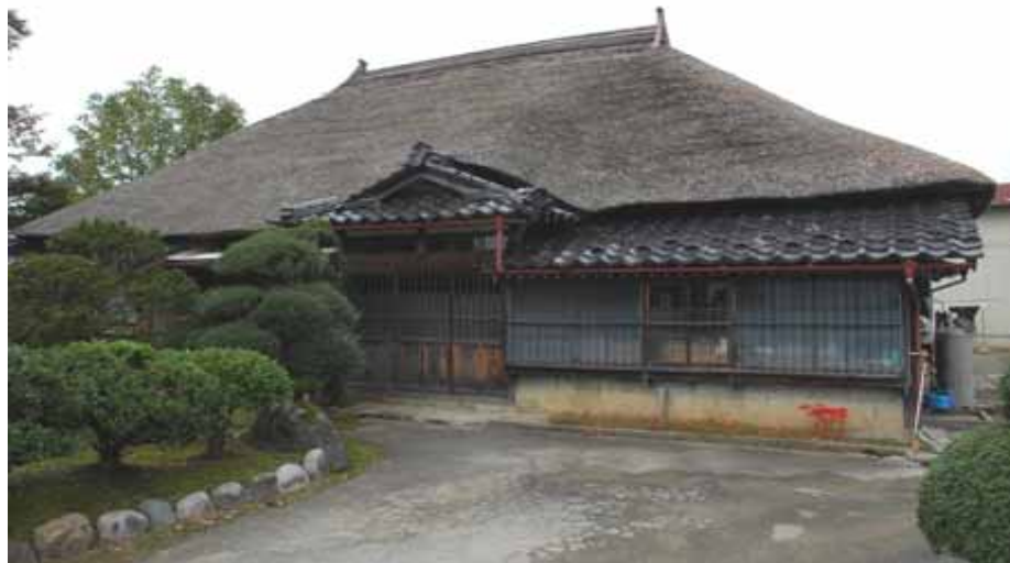
ほとんど見なくなった茅葺き農家(鶴岡市)
